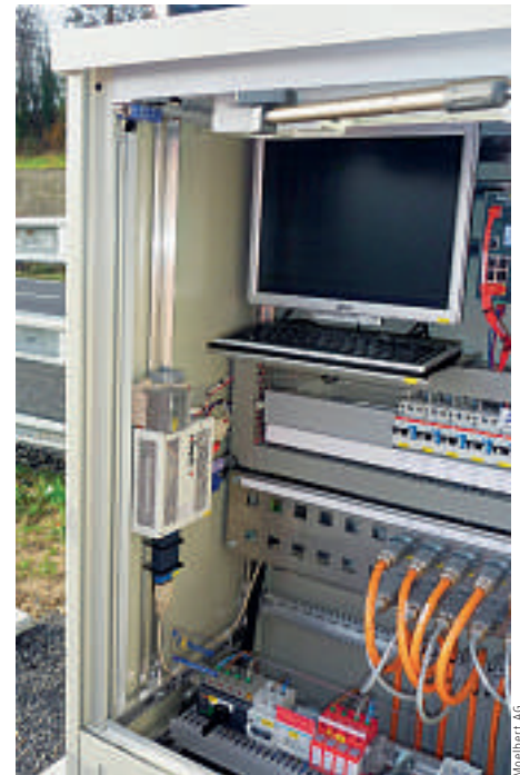
In den 25 Unterstationen zwischen Morges und Ecublens steuern Rechner aus der Syslogic-Compact-S-Serie (links aussen) die Signale
