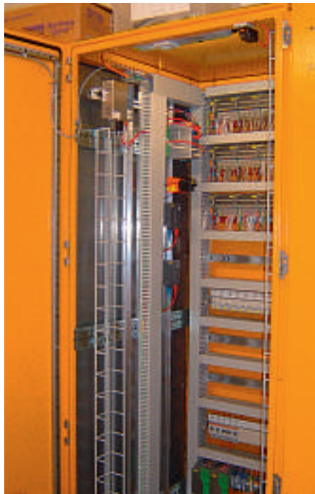
In den Tunnelzentralen der Westumfahrung Zürich steuern Syslogic-Compact-XS-Rechner (oberes Bildviertel) die Signale und Barrieren
