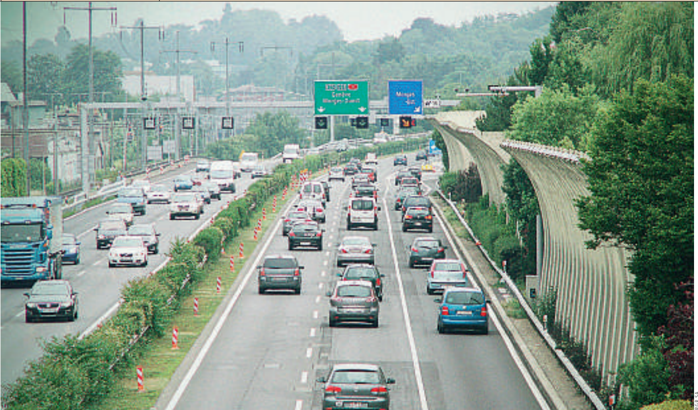
Zwischen Ecublens und Morges sorgt der Pannestreifen als zusätzliche Fahrspur für flüssigen Verkehr während der Stosszeiten
