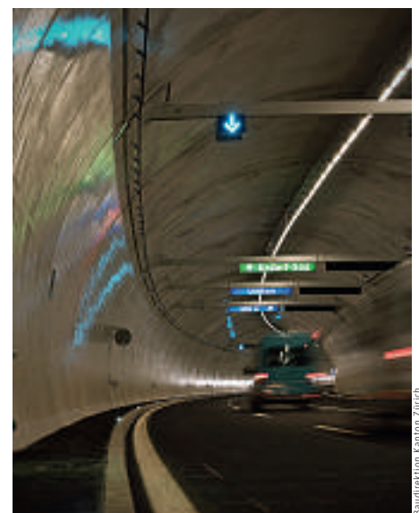
Für die Westumfahrung realisierte Moelbert die Verkehrsleittechnik, so auch die Steuerung der Fahrstreifensignale im Hafnerbergtunnel
