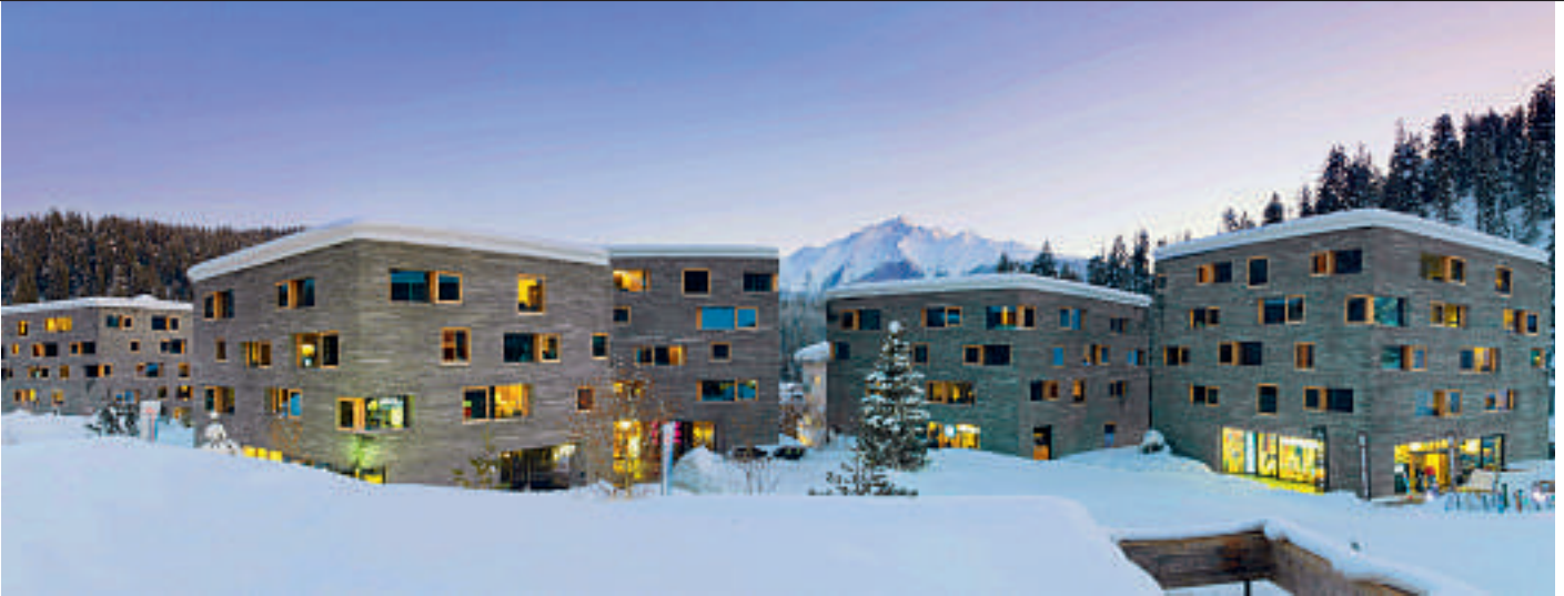
Das Schweizer Skigebiet Laax setzt ein zentrales Überwachungs- und Steuerungssystem für die Gebäudeautomation ein
